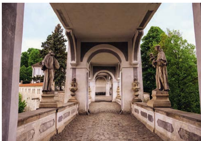
Spodní část mostu
