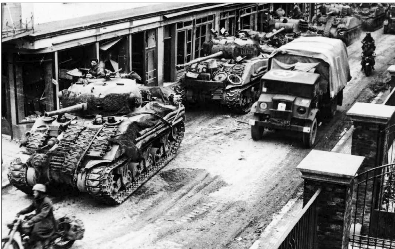
Zastávka kolony tanků M4 Sherman během průjezdu městem. Druhý tank v koloně je vyzbrojen výkonnějším sedmáctiliberním kanónem (ráže 76,2 mm), první stroj má ve věži původní kanón ráže 75 mm.
