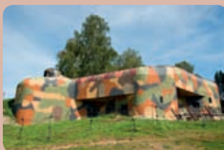
Pěchotní srub Březinka
