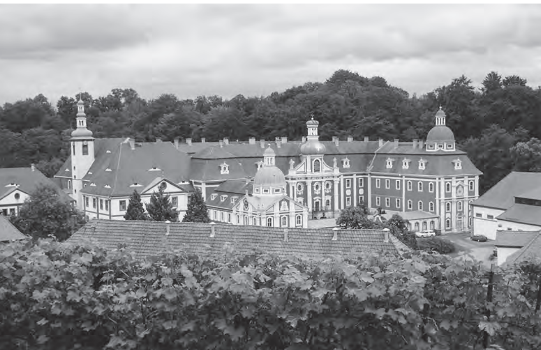
[1] Celkový pohled na klášter Marienthal. Barokní architektura dnes nepřipomíná jeho středověký původ.
