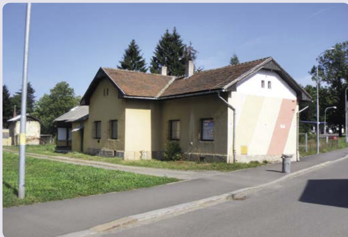
▲ Nezaměnitelná drážní architektura vám snadno prozradí, že tato budova je bývalým nádražím v Přibyslavi, ačkoliv už svému účelu dávno neslouží
