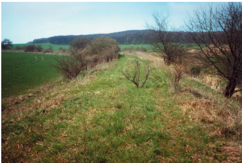
1. Nejběžnějším pozůstatkem zrušených tratí bývá kolejí zbavené traťové těleso. Trať Smidary – Vysoké Veselí, traťové těleso mezi Hrobičanami a Chotělicemi, duben 2001.
