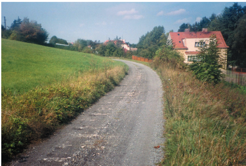
3. Traťové těleso zrušených drah často slouží jako místní komunikace, polní či lesní cesta. Trať Hrochův Týnec – Chrást u Chrudimi, traťové těleso se v současnosti používá jako cesta z Hrochova Týnce do Skalice, září 2002.
