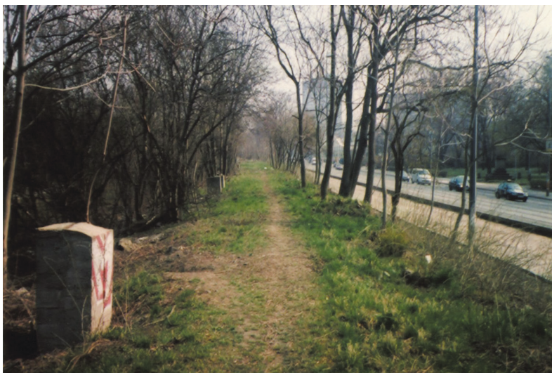
2. Trať Praha-Vysočany – Praha-Těšnov, traťové těleso podél Sokolovské třídy v Karlíně, duben 2004.
