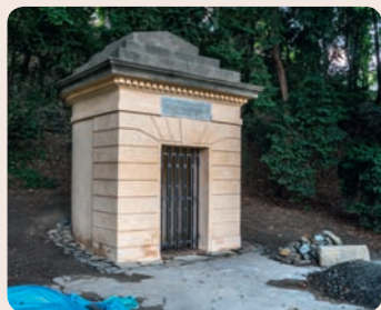
Altán je nově opravený.
