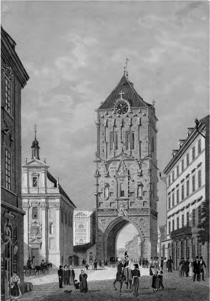
2. Hodiny na Prašné bráně, pohled od Celetné ulice, oceloryt Vincence Morstadta a Václava Merklase Der Pulverturm, Ansicht von Westen, 1852
