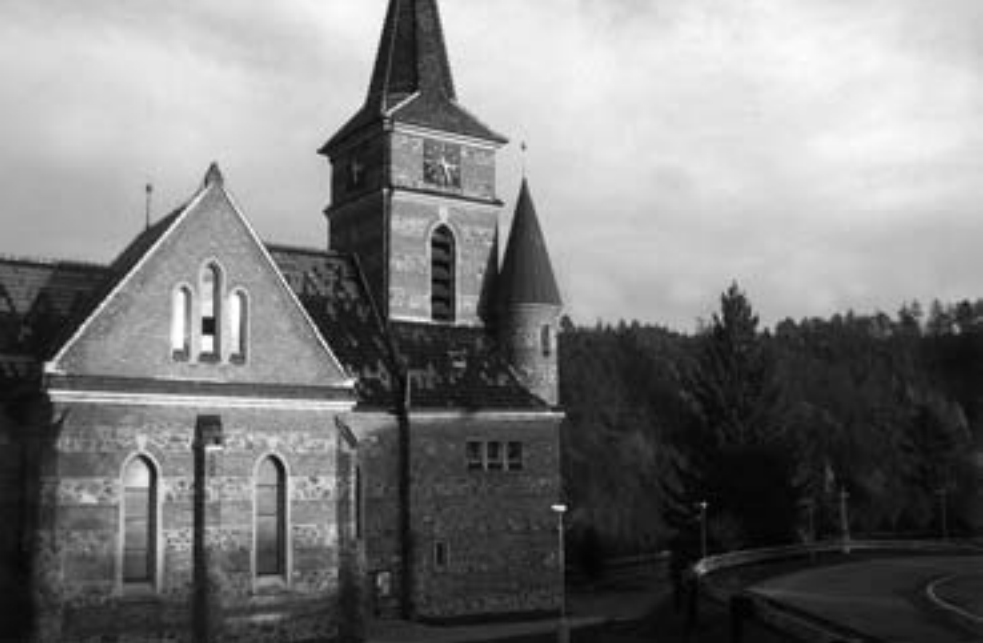
Obnovený kostel v Bílovicích
