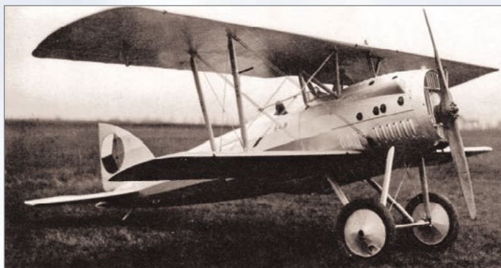
↑ Letov Š-4 po rekonstrukci s novými ocasními plochami a novým chladičem motoru
