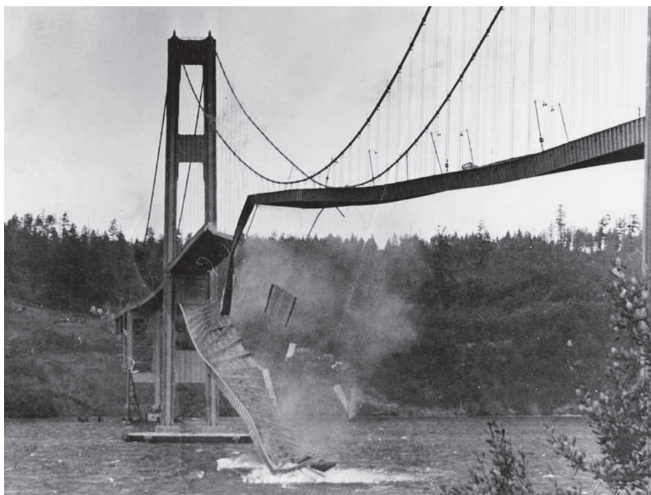
Obr. 9.1 Pohlednice zachycující zřícení Tacomského mostu způsobené silným větrem.
