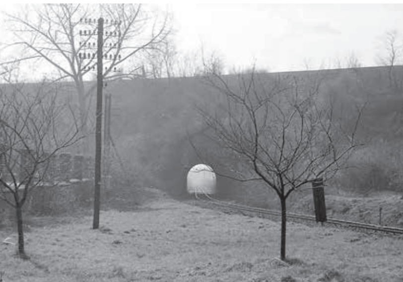
V náspu vítkovské trati byl pro těšnovskou trať vytvořen tunel. Jeho délka byla dána velkou výškou náspu a mírným sklonem jeho svahů. Foto Vlastimil Novotný, sbírka Josef Bosáček.
