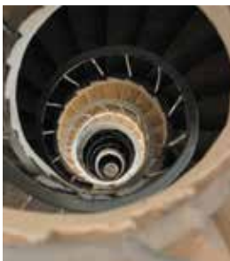
Schodisko v minarete
