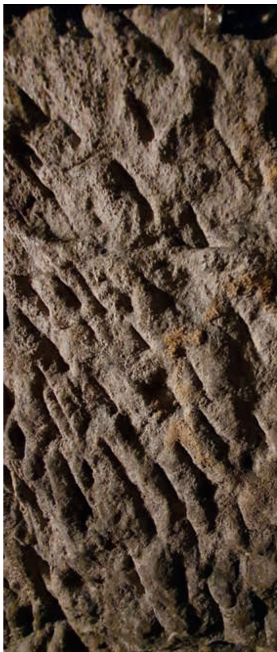
19. Detail chodby v pískovcovém podloží – tesáno ručně pomocí želízka a mlátku (červenec 2020)
